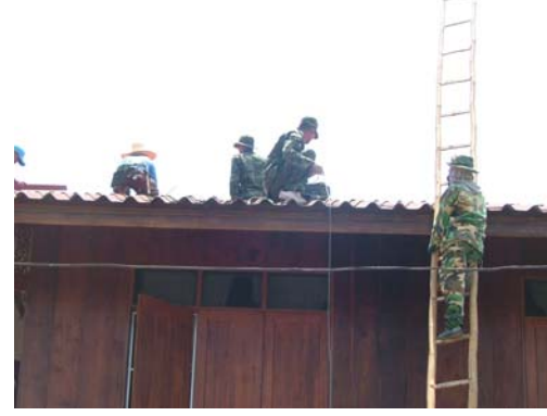
บรรดาพลทหารช่วยซ่อมแซมบ้านเรือนราษฎร ที่ได้รับความเสียหายจากพายุฤดูแล้ง
